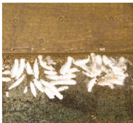
Wachsmottenfraß unter dem Boden, vordere Kufe. Bleiben solche Hohlräume, nisten sich wiederholt Motten oder Ameisen ein und die Zerstörung geht immer weiter.
