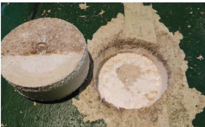
Das einzusetzende ausgesägte Reparaturstück liegt bereit.
