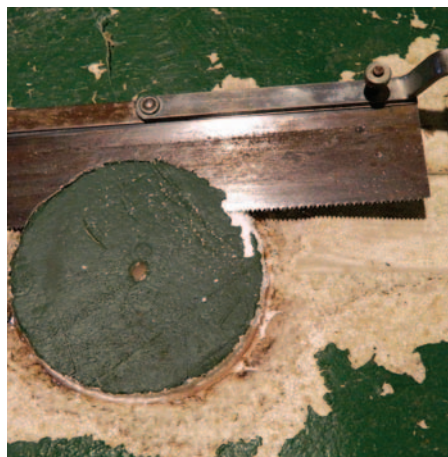
Der Überstand wird abgesägt.
