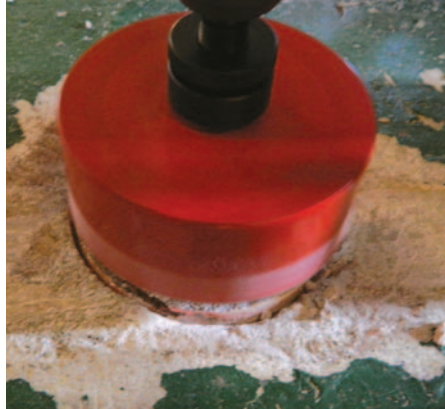
Mit der Lochsäge wird die schadhafte Stelle herausgesägt.
