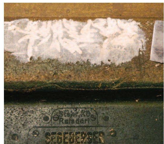
Hier wird ganz einfach zugespachtelt, dann übergeschliffen, etwas Farbe drauf, - fertig.
